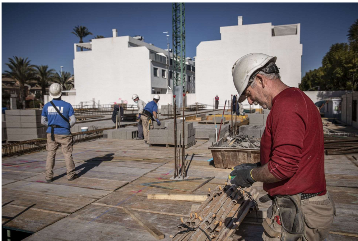
Trabajadores de la construcción, en una localidad de Valencia. MÓNICA TORRES
